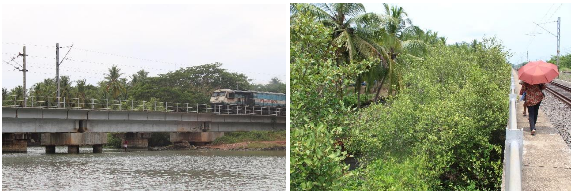
Fotografia 4- Ferrovia que passa no meio da RCKV
